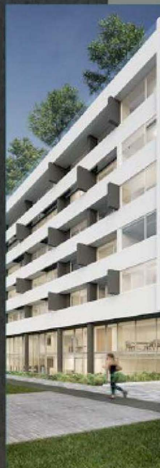
EDIFICIO ALBORA Santiago Centro
